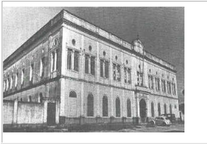
Primeira instalação do Tribunal de Contas do Estado do Pará, instalada em 1953 (a dependência ocupada pelo Tribunal de Contas era a sala de canto à esquerda, no pavimento superior), onde atualmente funciona a Universidade do Estado do Pará. Fonte: Site do TCE-PA
